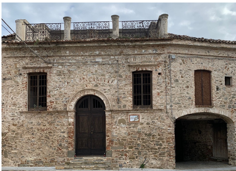
Figura 2 Prospetto principale o prospetto Nord, pre-2022
